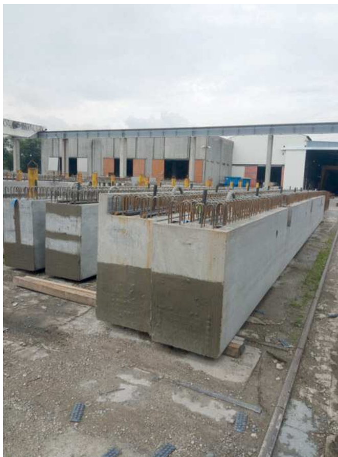
Travi R dopo lo scassero in magazzino durante la fase di maturazione naturale nella fabbrica di Grigny.
