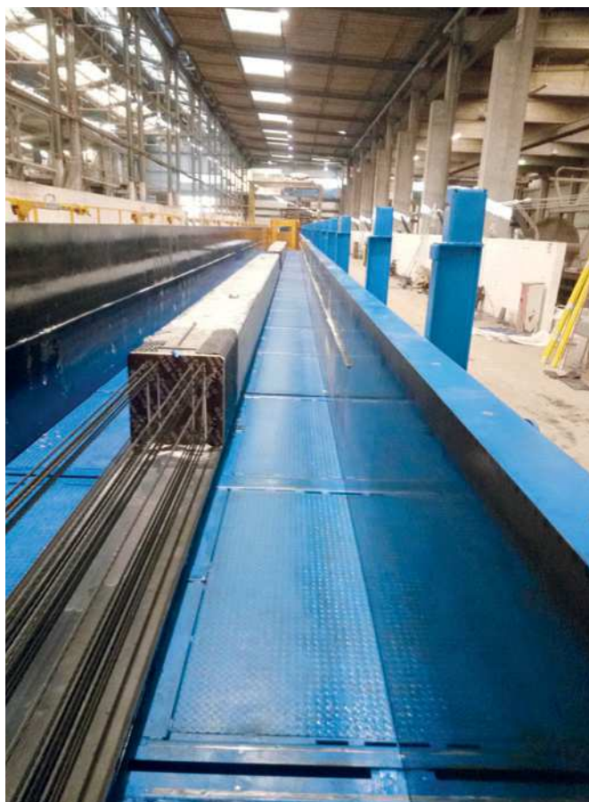
Vista dei cilindri di rilassamento e collari di sicurezza montati sulla testata di ancoraggio trefoli
