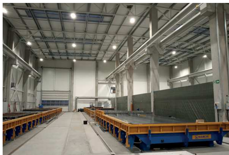
Produzione pannelli prefabbricati, vista dei banchi completi di sponde ed armature pronti al getto.
