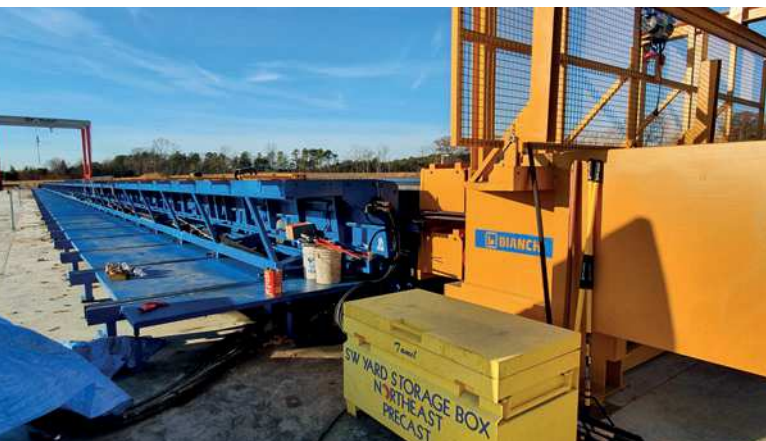
Cassero TT installato
