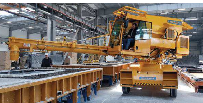
Le distributeur de béton « Speedy » lors du coulage
