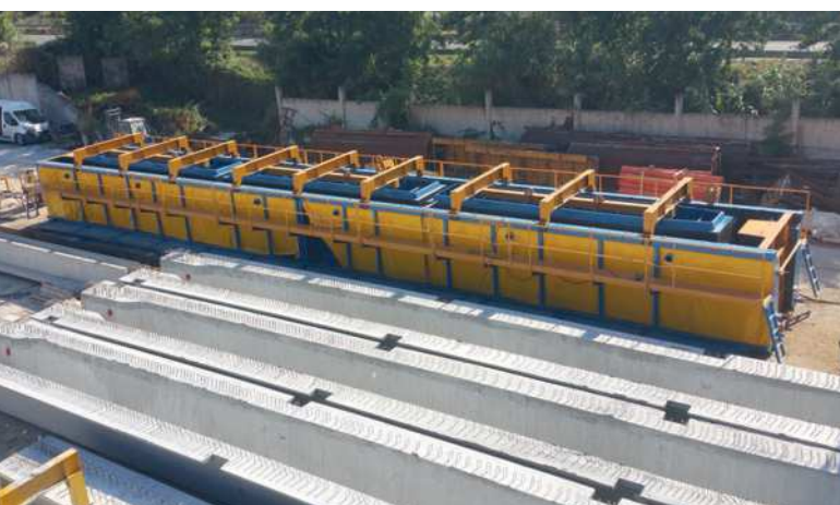
Вид с воздуха на опалубку и предварительно напряженные мостовые балки
