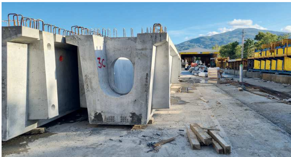
Предварительно напряженные мостовые балки, вид спереди
