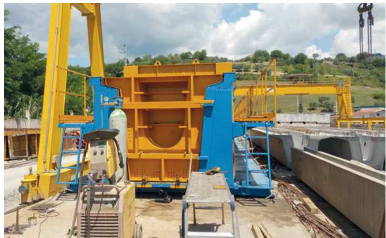
Форма, вид спереди. Опалубка, вид спереди
