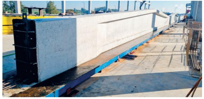
Viga con inclinación doble
