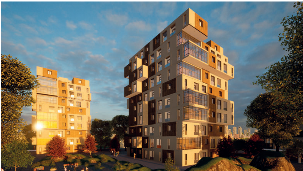
Edificio de viviendas de varias plantas, construido con módulos con la tecnología PPVC
