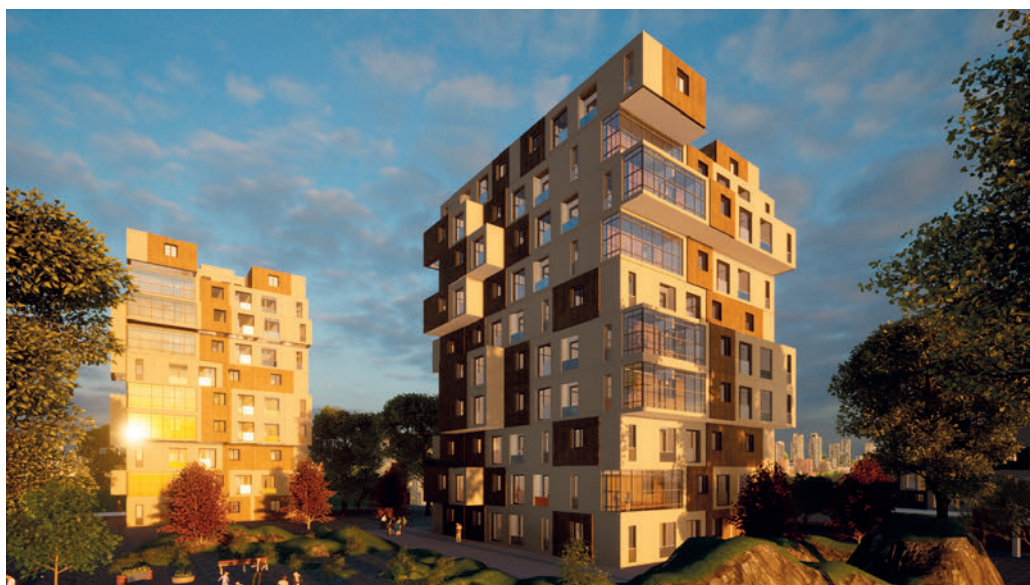
Edificio residenziale multipiano, realizzato con moduli in tecnologia PPVC
