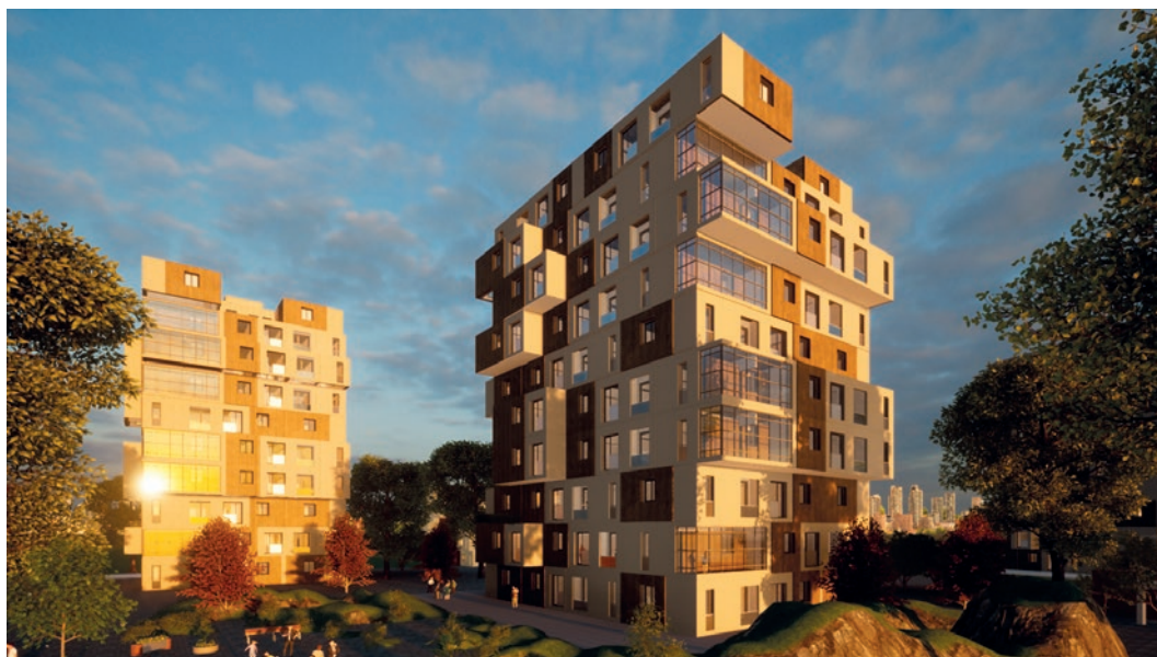
Budynek mieszkalny wielokondygnacyjny wykonany z prefabrykowanych modułów.
