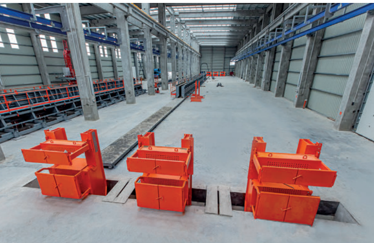
Planta de producción para la fabricación de vigas
