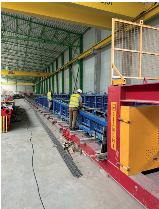
Producción de vigas rectangulares
