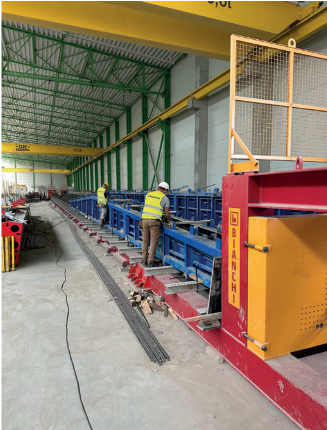
Fabrication de poutres rectangulaires
