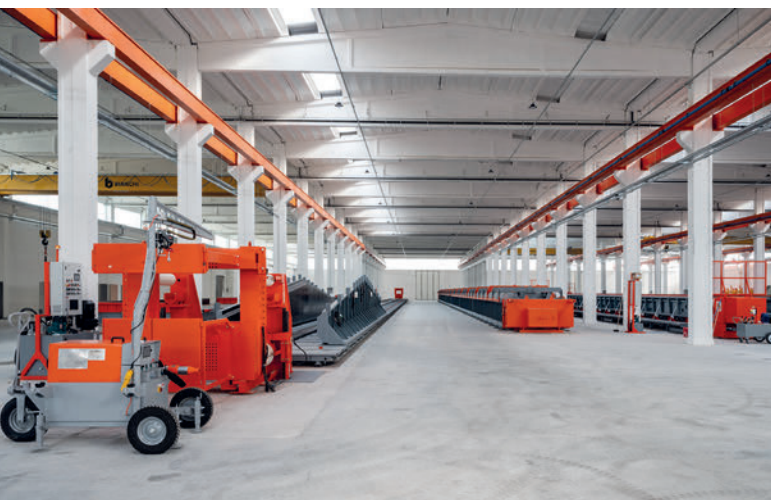
Vista general del encofrado, carriles de la grúa y encofrado de alas
