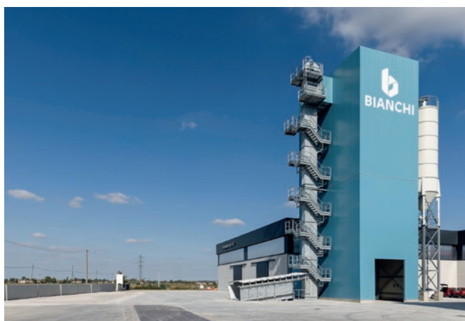
Bianchi Prefabbricati - widok z zewnątrz.
