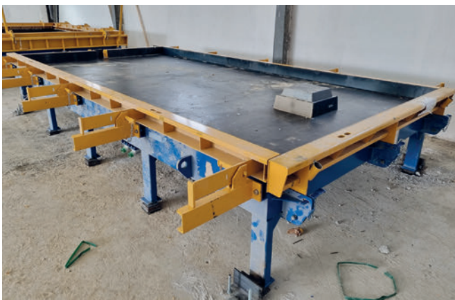
Passerelle, parapetti e scale di accesso alla parte superiore del cassero
