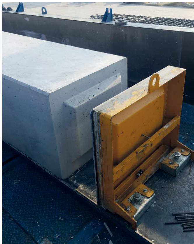
Scassero di un pilastro con particolare base diamantata
