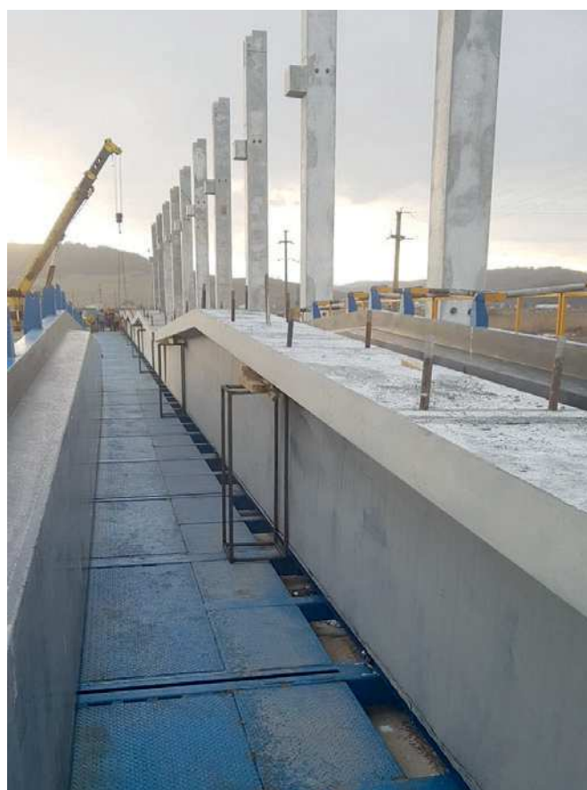
Pista travi precomprese con a fianco montaggio pilastri per auto-costruzione del capannone
