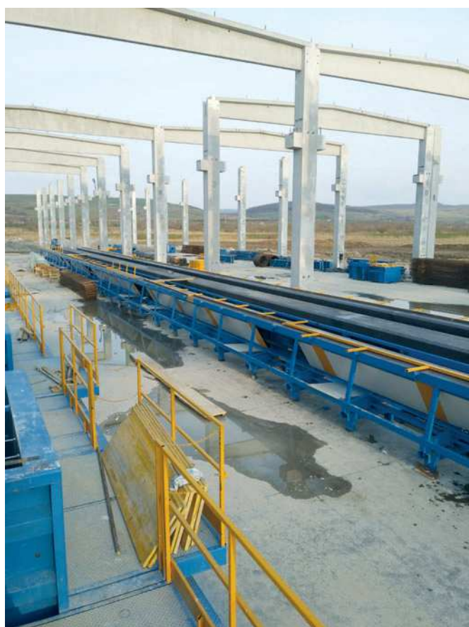
Il cantiere di Samus durante l'auto-costruzione del capannone con vista delle Casseforme Bianchi
