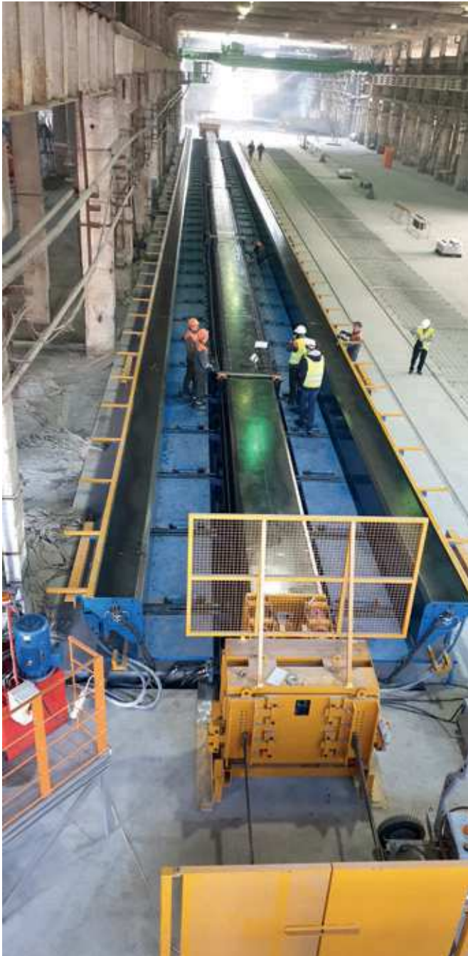
Vue aérienne du coffrage TT
